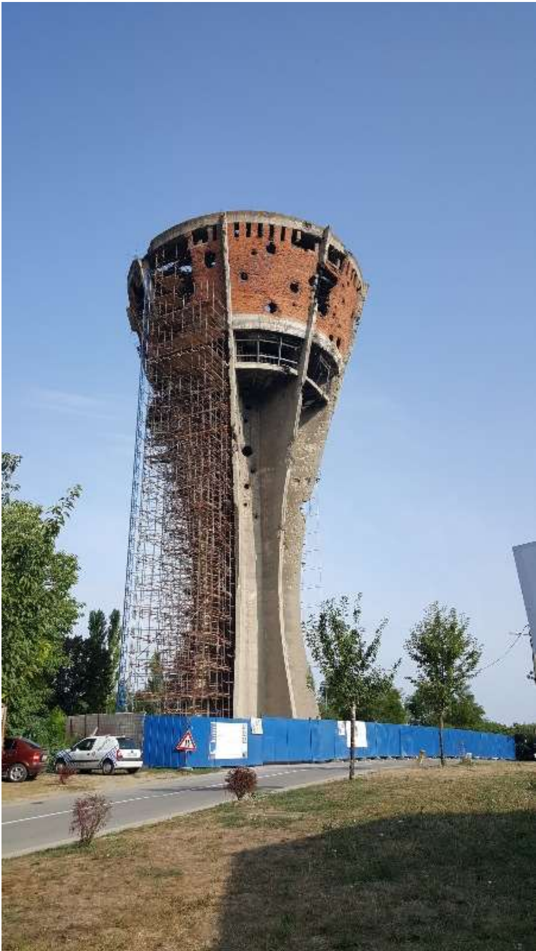
Der zerschossene Wasserturm wird zu einem Museum umgebaut
